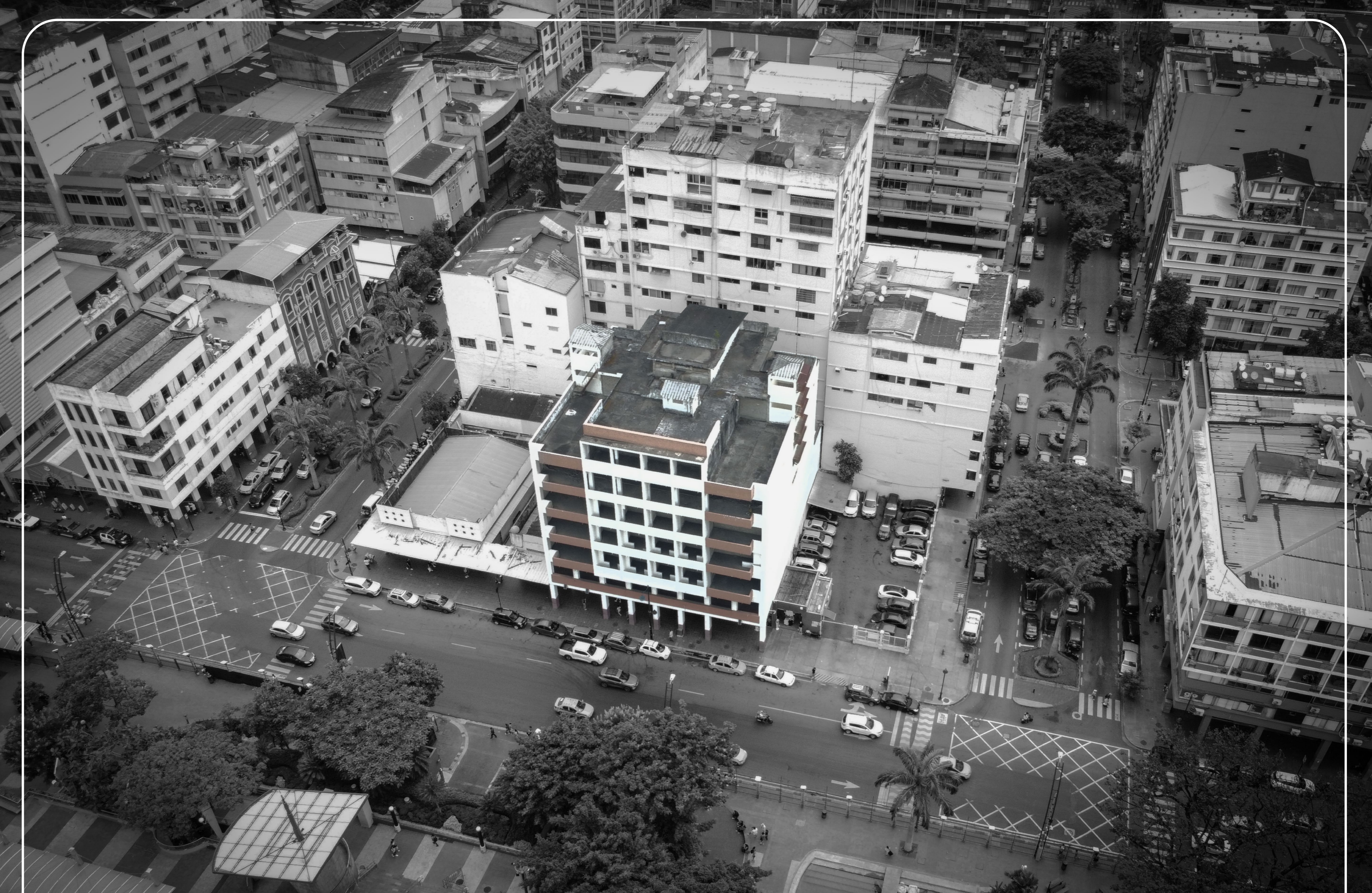
Entorno Inmediato al edificio Bertullo, Guayaquil - Ecuador 2024
