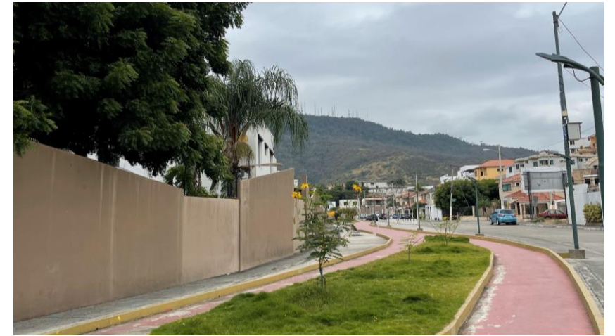
Fotografía de los cerramientos en Cdla. La Cumbre (Campos, 2024)
