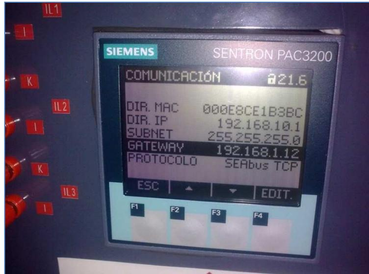
**Figura N° 4. 28 Direccionando IP para interconexión.**
