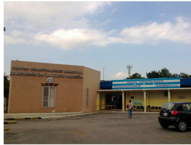
ILUSTRACIÓN 32 – Ingreso del Centro Gerontológico «Dr. Arsenio De La Torre Marcillo».
