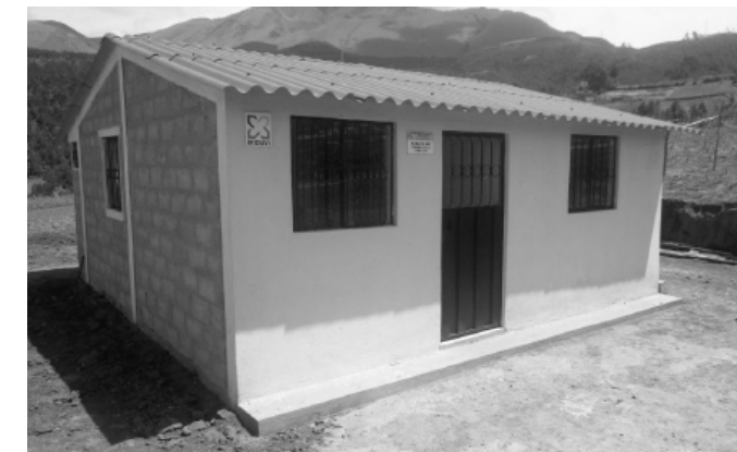
Figura 9: Vivienda del MIDUVI para proyectos rurales
