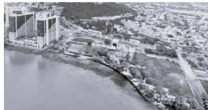
Figura 32: Vista Aérea desde la Av. Pedro Menendez Gilbert
