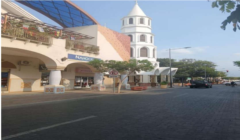
Figura 1: La figura representa la regeneración urbana después del terremoto del 2016
