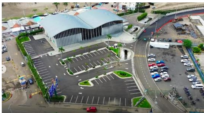
Instalaciones de la Terminal Internacional de Cruceros de Manta
