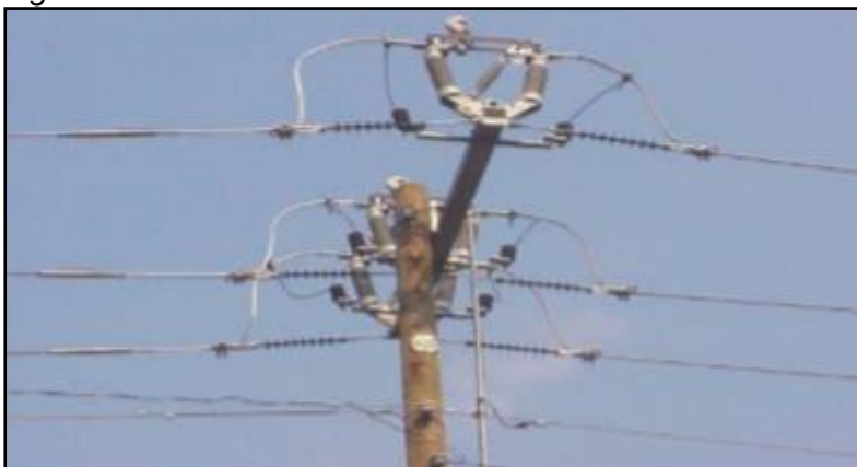
Figura 2.12: Cuchilla seccionadora.
