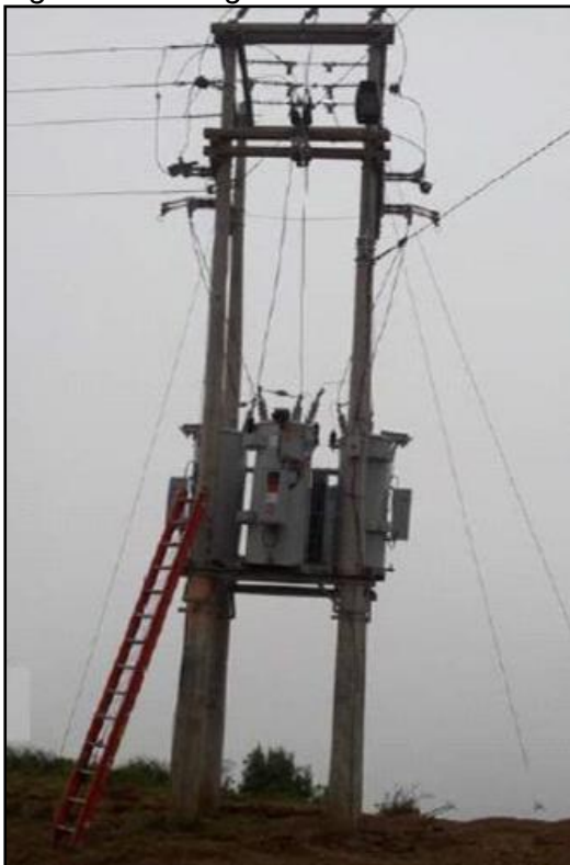
Figura 2.15: Reguladores de tensión.
