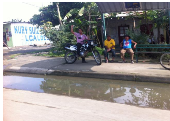
Figura 5. Vía con empozamiento de AA.LL.
