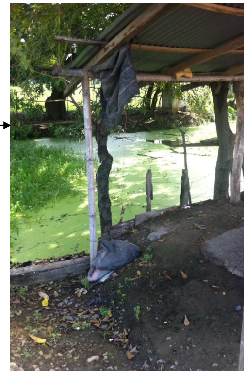
Figura 58. Estructura en el sitio
