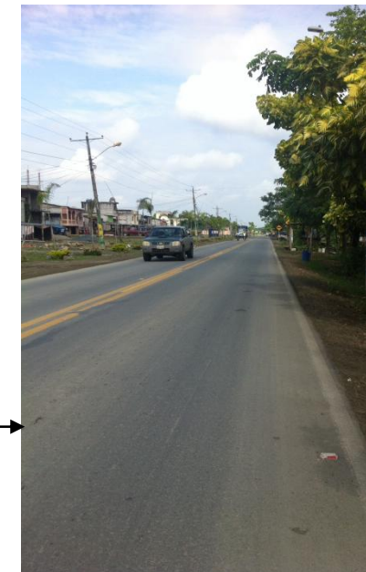
Figura 46. Carretera Guayaquil - Salitre Fuente: Yturalde (2014)
