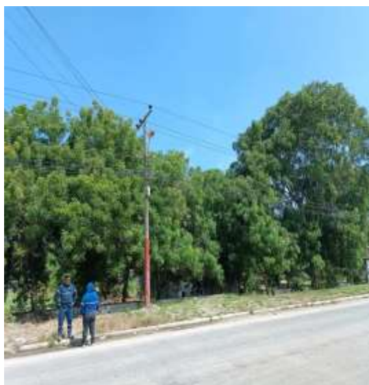
Figura 23 Punto de referencia para los bancos de reguladores de tensión
