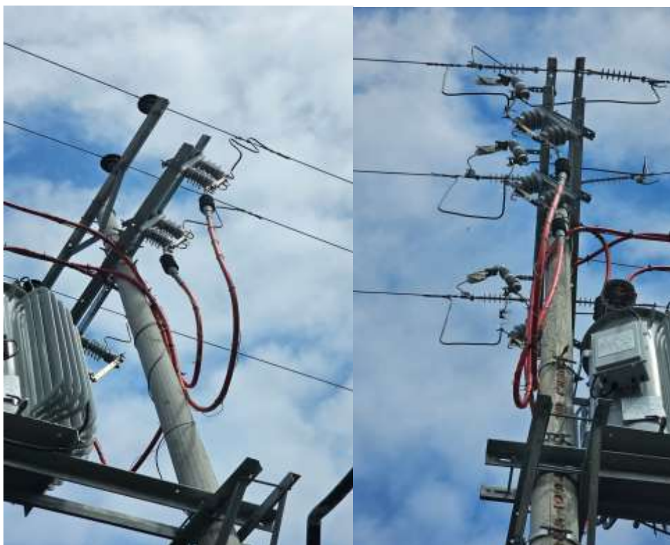
Figura 28 Instalación de los seccionadores laterales
