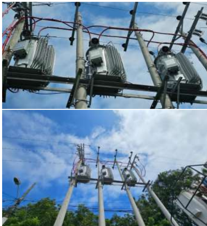
Figura 27 Instalación del Banco Regulador
