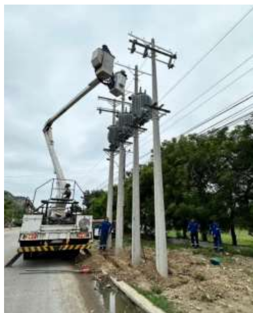
Figura 25 Trabajos en los Bancos Reguladores
