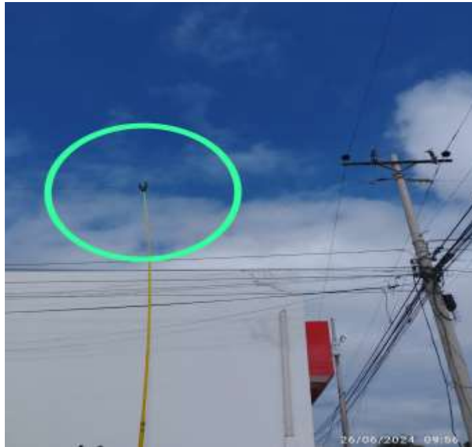
Imagen 5 Fotografía Mediciones, Realizadas en arranque monofásico
