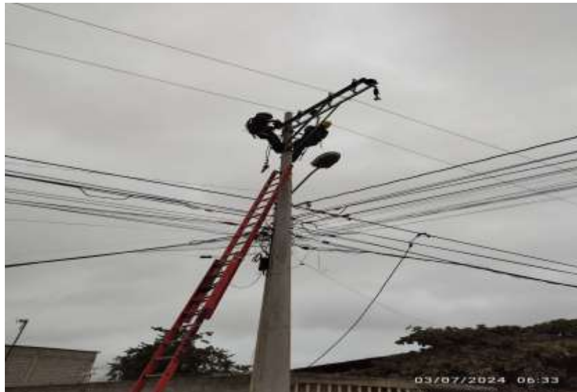
Imagen 30 Trabajos En Estructuras De Media Tensión
