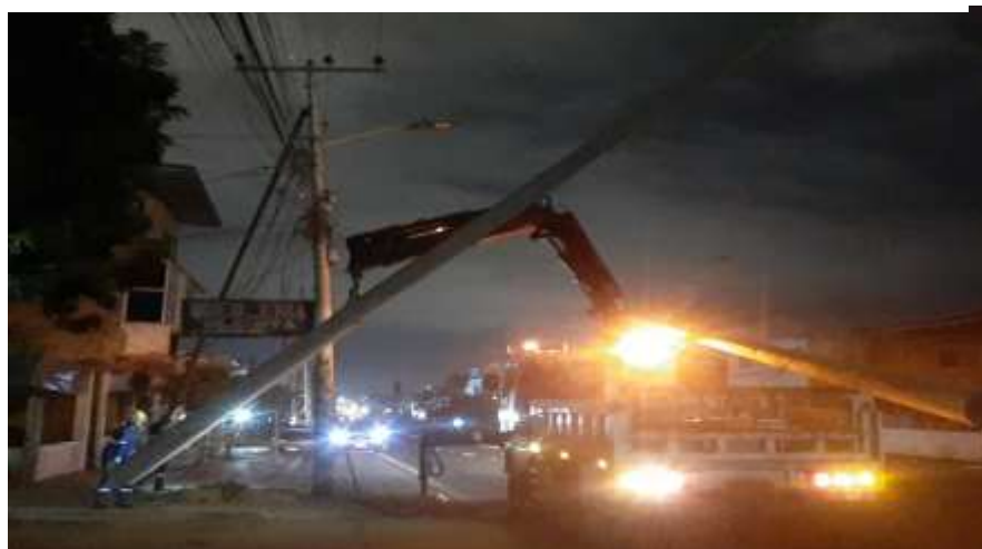
Imagen 28 Cambio de postes de media tensión
