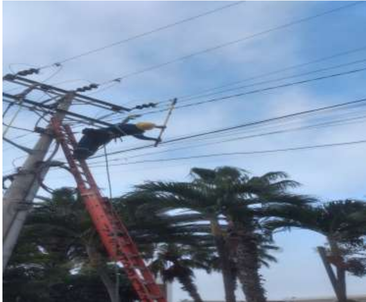
Imagen 16 instalación De Grapa Línea Viva, Puente Roto
