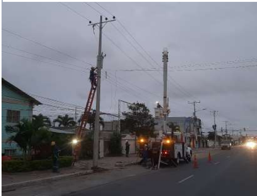
Imagen 32 Vista Panorámica realizando trabajos
