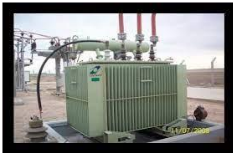
figura 3-6: Conexión del neutro-tierra en un transformador
