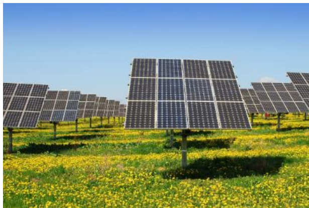
Figura 1: Energía solar fotovoltaica Fuente: (Energía, 2022)
