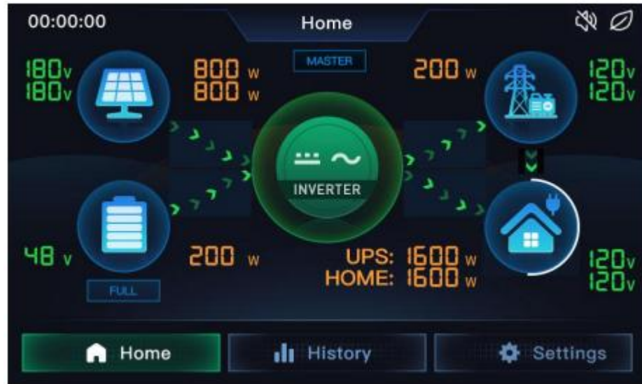
Ilustración 17. Display del panel principal del inversor.
