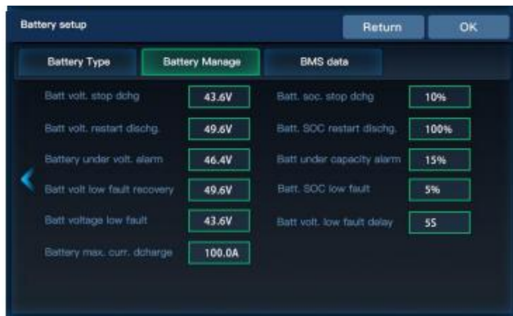
Ilustración 20. Interfaz para la configuración de los parámetros de gestión de la batería
