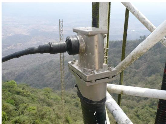
*Figura 3.21: Guía de Onda Elíptica conectada a Antena de Transmisión*
