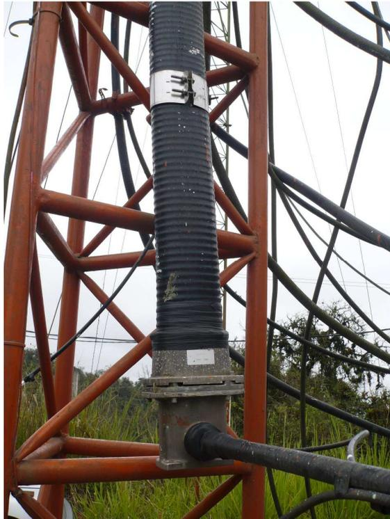
*Figura 3.20: Guía de Onda Elíptica conectada a Transmisor de Potencia*
