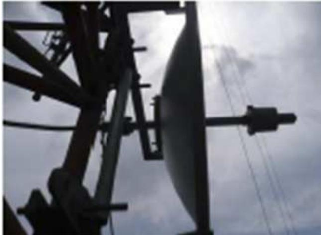
*Figura 3.24: Antena de Transmisión/Recepción MMDS, vista de perfil*
