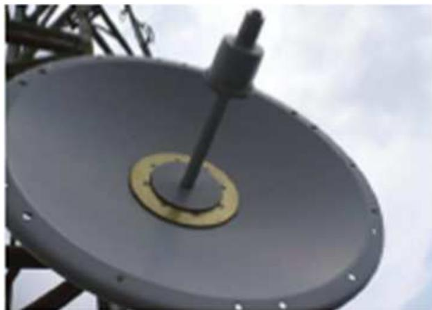
*Figura 3.23: Antena de Transmisión/Recepción MMDS, vista frontal*
