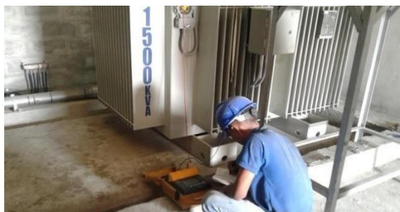
Figura 12: Mantenimiento a transformador de 1500 kVA
