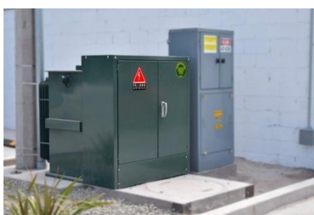
Figura 6: Transformador tipo pedestal
