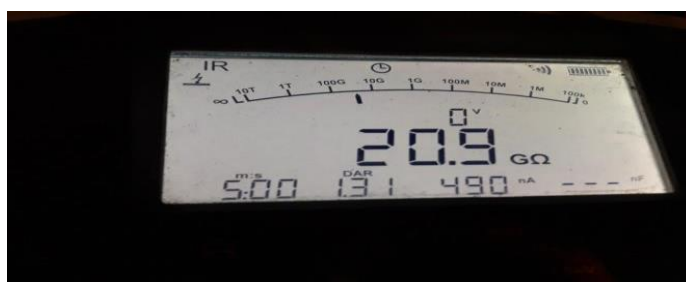
Figura 13: Prueba realizada a equipo de distribución con el equipo megger mit-1525
