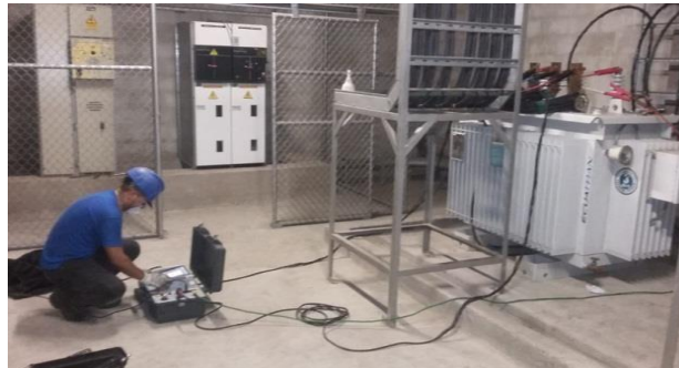
Figura 15: Mantenimiento al equipo de distribución al año siguiente
