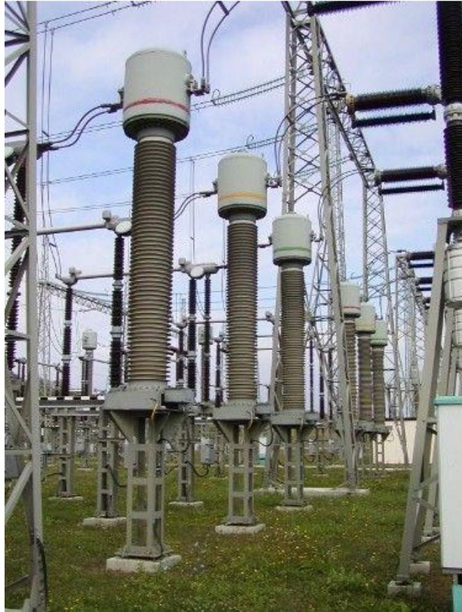
*Nota: Transformador de corriente MR 100/50/25:5 72.5kV Fuente: Crompton Grid, 2014*
