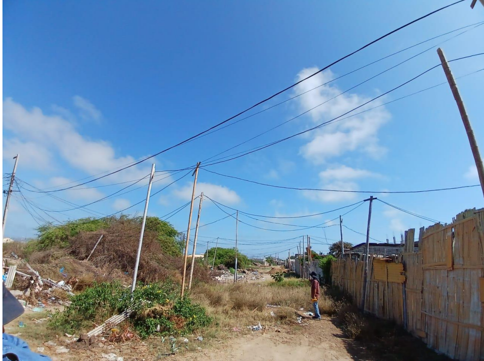
Figura 16. Imágenes de acometidas aéreas clandestinas manzana 8.
