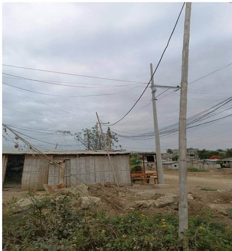
Figura 19. Imágenes de acometidas aéreas clandestinas manzana 11.
