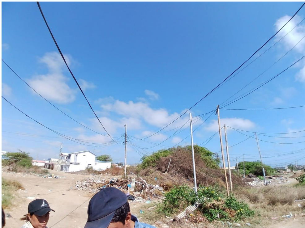
Figura 17. Imágenes de acometidas aéreas clandestinas manzana 9.
