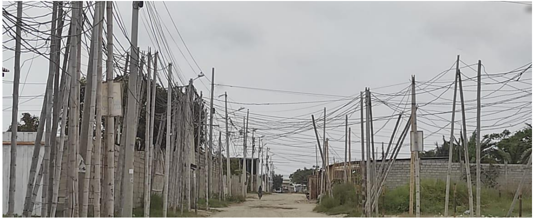
Figura 18. Imágenes de acometidas aéreas clandestinas manzana 7.
