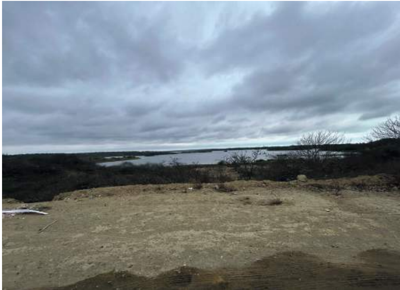
Figura 5. Humedal Velazco Ibarra excavaciones de tierra Elaboración propia
