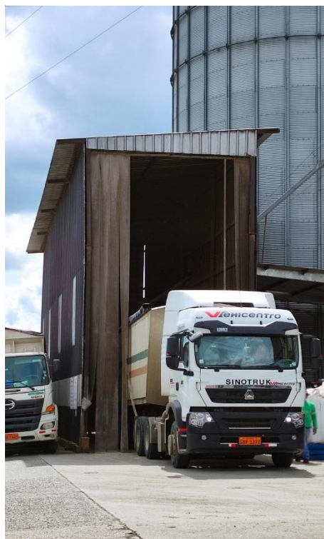
Ilustración 2 - Ingreso de Camiones al Área de Descarga al Granel
