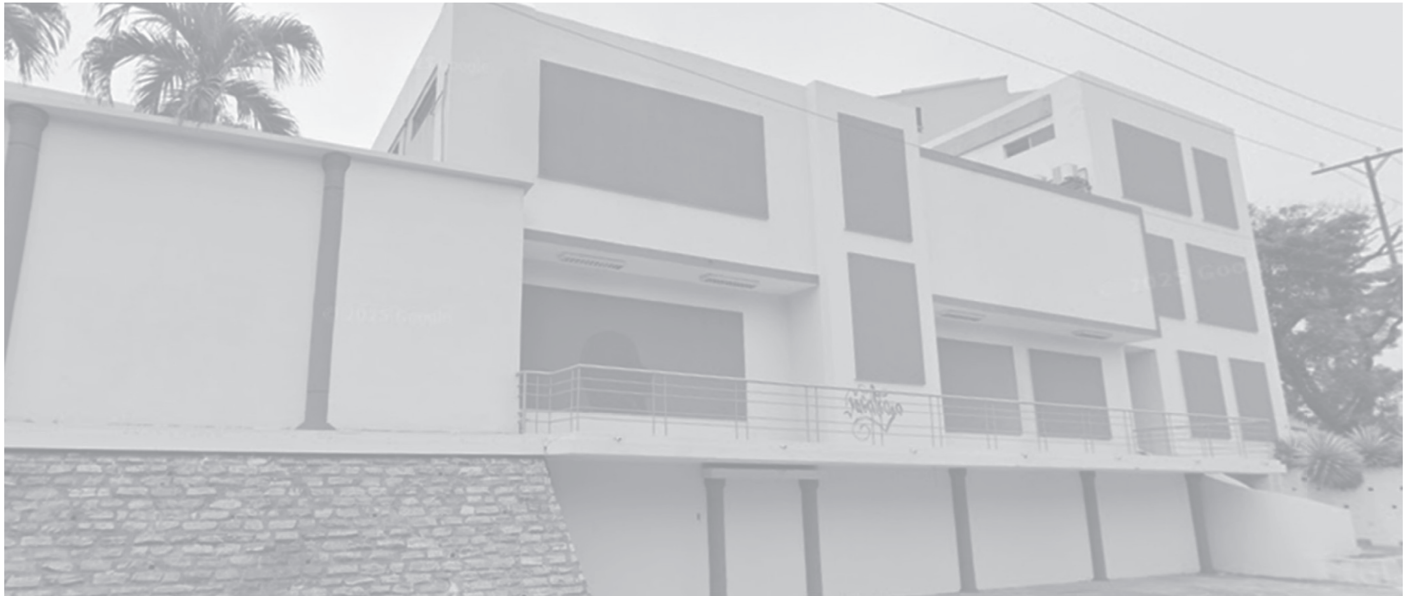
Figura 6. Estado actual de la Casa Calderón / Antiguo Centro de Idiomas. Fuente: Elaboración Propia. (2025)
