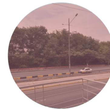
Fig. 8: Fachada Frontal Fuente: Elaboración propia
