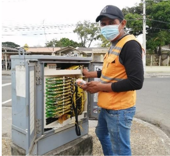
Figura 3.7: Mediciones ópticas en las salidas de los puertos de la OLT
