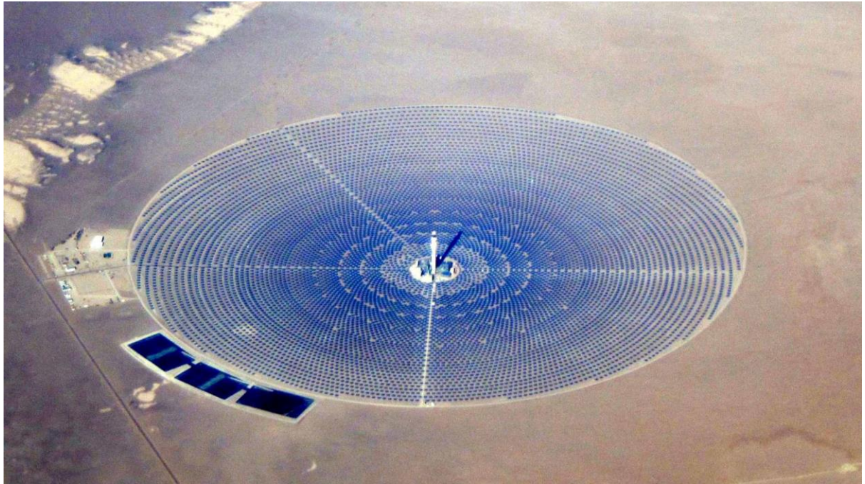
Figura 6. Central solar térmica
