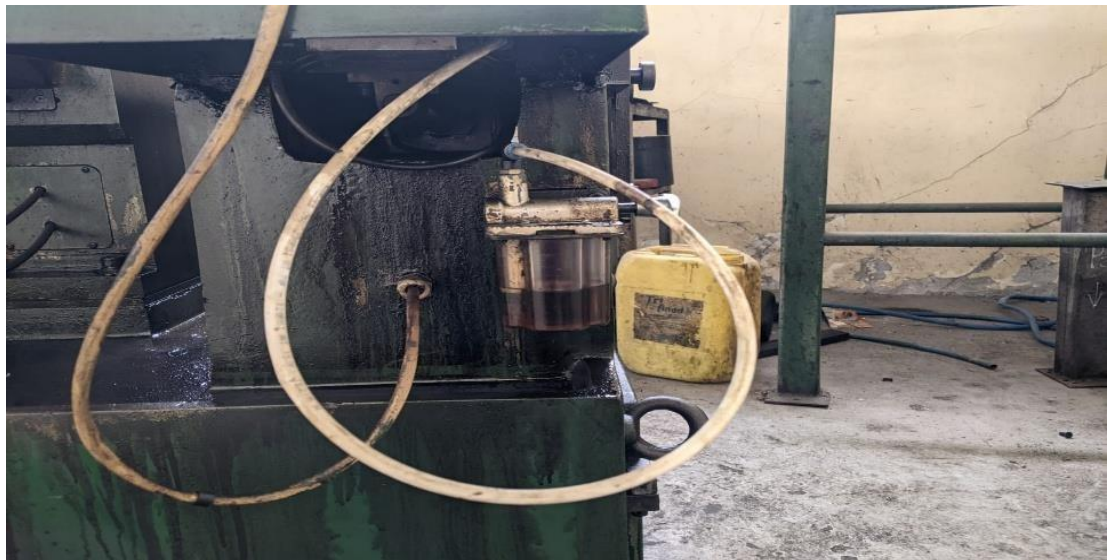
Figura 29. Cambio de tuberías de lubricación manual 2026
