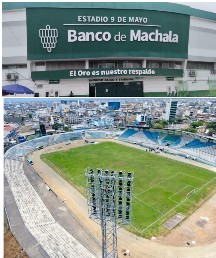
Figura 25 Vista principal del estadio 9 de mayo.
