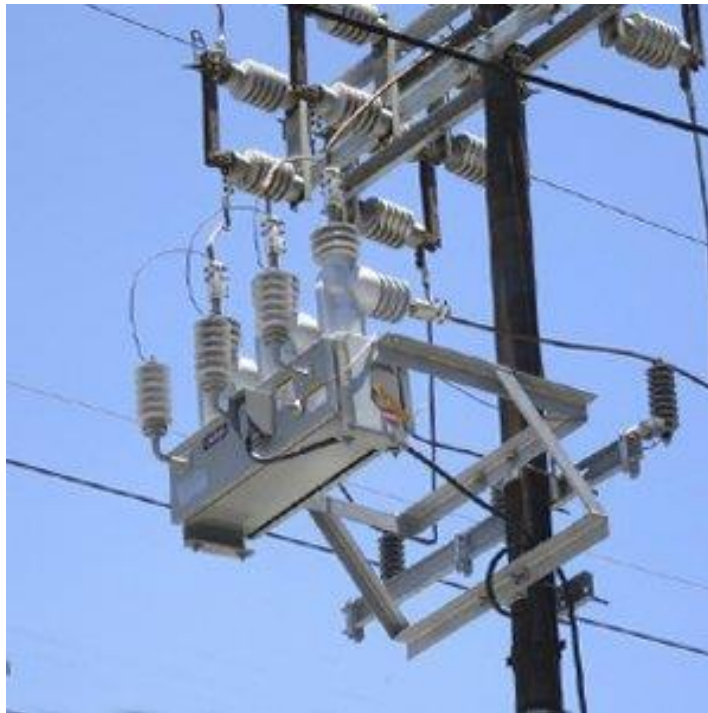
Figura 16 Restaurador eléctrico para sistemas desde 15.5 hasta 38 KV.
