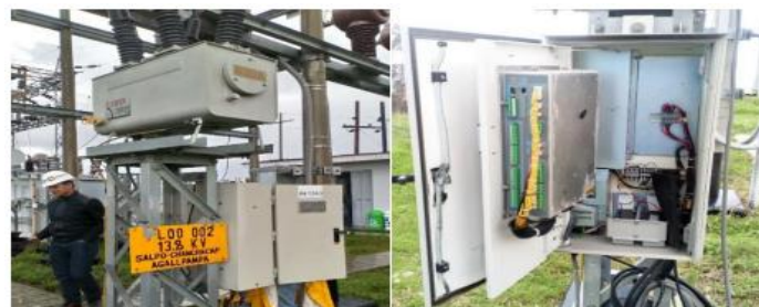
Figura 34 Inspección equipos en planta
