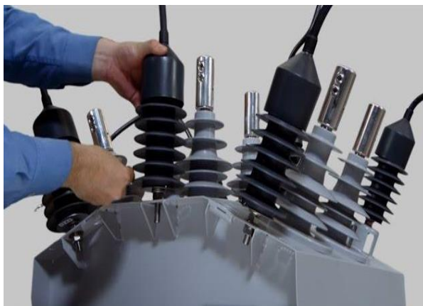
Figura 29 Instalación de cables y protectores
