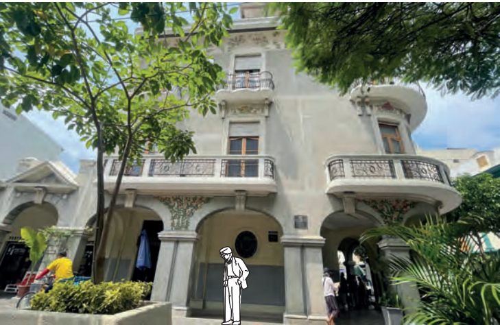
Figuras 1 & 2. Fotografías actuales de la Calle Panamá, de Consultoría Técnica para la Intervención de la Calle Panamá – Empresa Pública Municipal de Turismo de Guayaquil [Fotografía], 2020.
