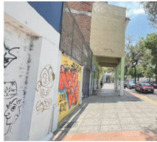
Edificaciones descuidadas. Fuente: Elaboración Propia
