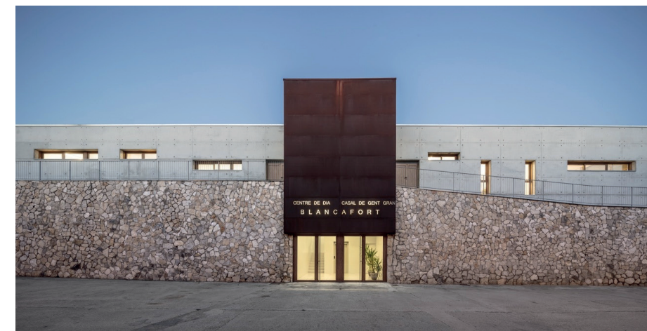
Figura 15: Acceso generado en el muro de contención
