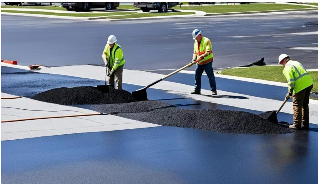
Ilustración 7. Extendido manual de mezcla asfáltica en caliente para la conformación de la carpeta de rodadura. Fuente: Asfalto Farvias. Carpeta asfáltica en caliente.
