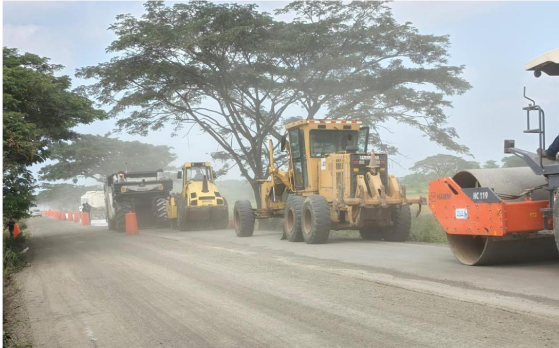
Ilustración 10. Ejecución de la estabilización in situ de una base mediante la técnica de Materiales Estabilizados con Betún (BSM). Fuente: Autor.
