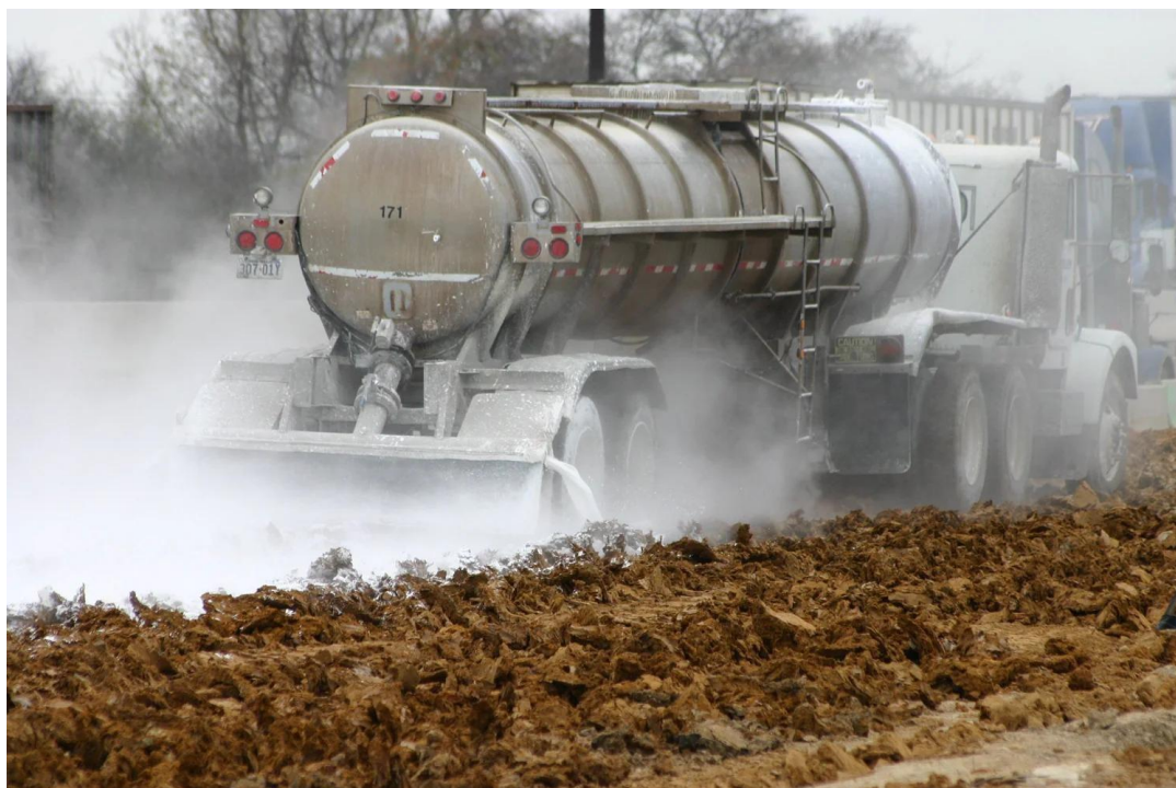
Ilustración 12. Aplicación de un estabilizante químico líquido durante el proceso de estabilización de suelos. Fuente: Compraco. Estabilización del suelo: métodos químicos y mecánicos.
