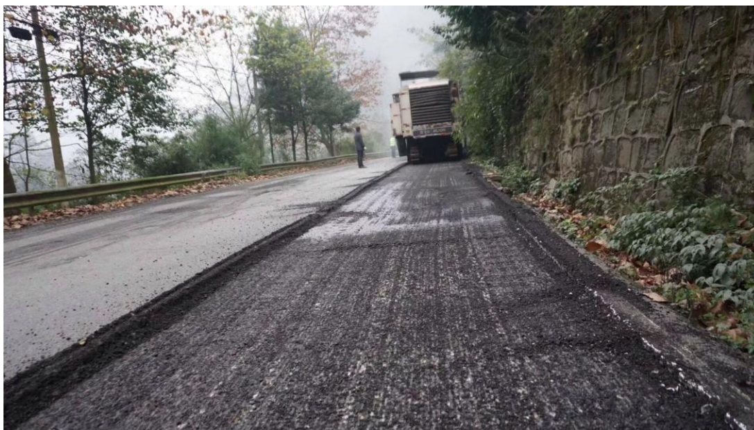
Ilustración 9. Fresado de un pavimento flexible como parte del proceso de rehabilitación vial. Fuente: EVERPADS. The Ultimate Guide to Asphalt Millings: What They Are and How to Use Them for Your Asphalt Milling Needs.
