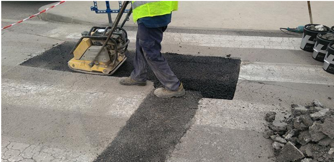
Ilustración 8. Reparación localizada de un pavimento asfáltico mediante bacheo con mezcla asfáltica en caliente. Fuente: Asfaltos Tudefran, Estrategias para el mantenimiento y la reparación de pavimentos asfálticos.
