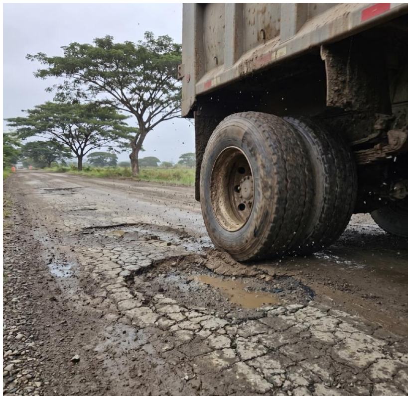
Ilustración 1. Vía por rehabilitar. Fuente: Autor.
