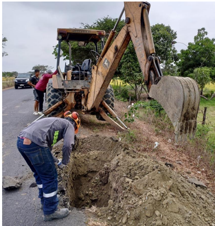
Ilustración 14. Exploración geotécnica mediante la ejecución de calicatas en la vía La Victoria – T de Baba. Fuente: Autor.
