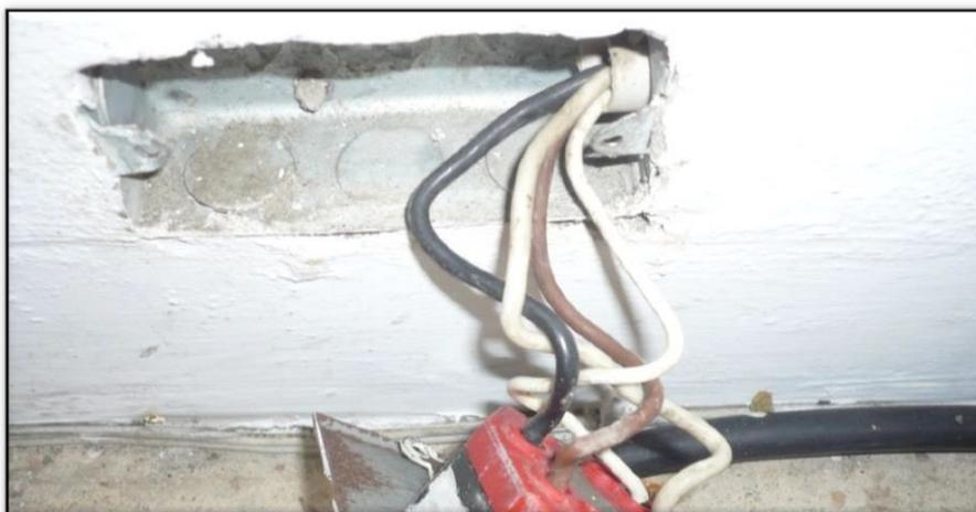
*Figura 3.19 Tomacorrientes no Polarizados*
