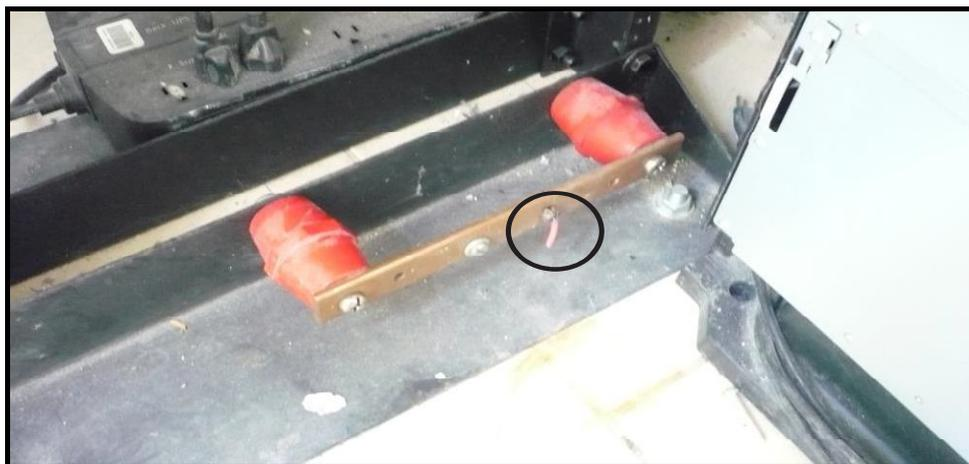
*Figura 3.3 Base del Bastidor no Protegida del Sistema de Puesta a Tierra*
