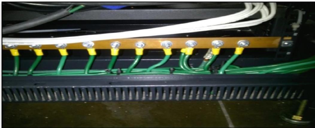
*Figura 2.11 Aterramientos de los bastidor*
