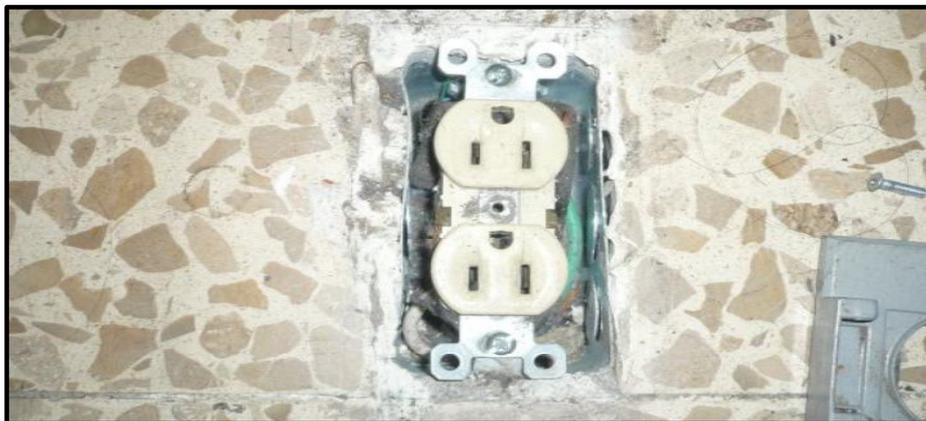
*Figura 3.13 instalacion empotrada de los tomacorrientes en el piso del laboratorio*
