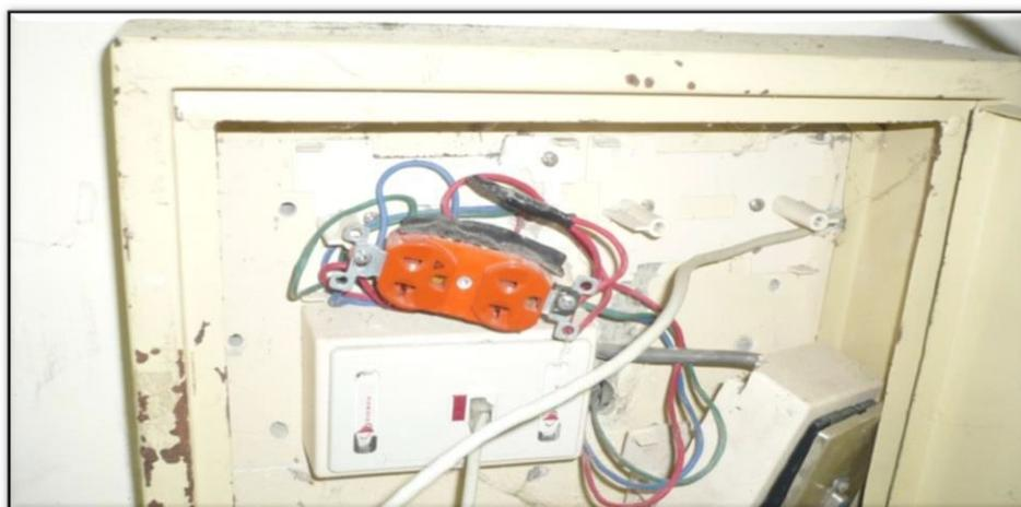
*Figura 3.12 toma corrientes de los UPS conectado a tierra*
