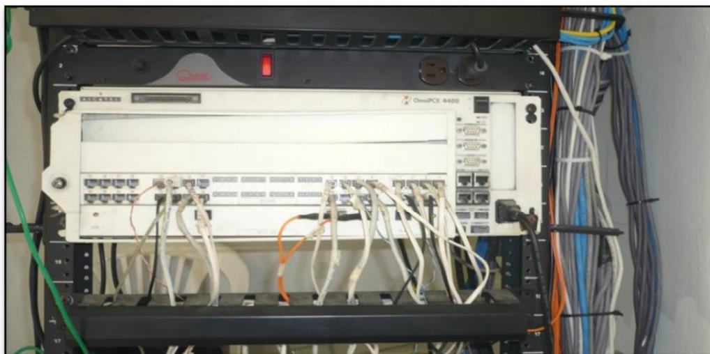
*Figura 3.5 conexiones deplorables en equipos de comunicación*
