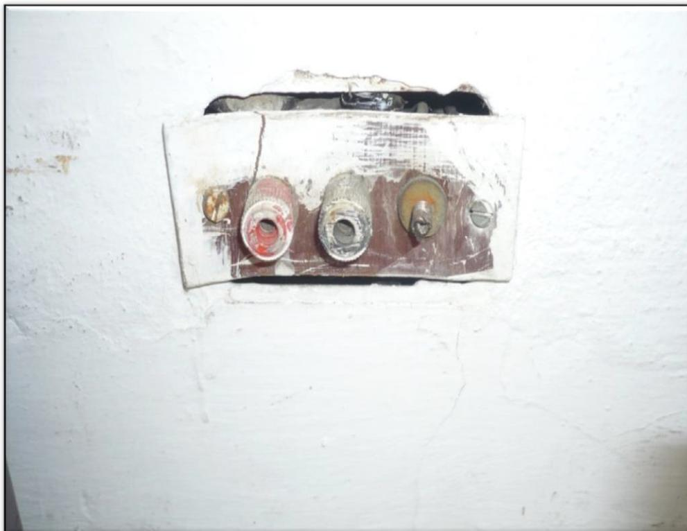
*Figura 3.18 plus de pruebas a tierra en mal estado*
