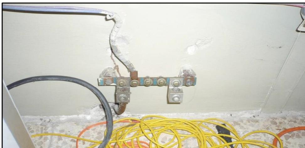
*Figura 3.16 conexión del sistema de puesta a tierra laboratorio de telecomunicaciones*
