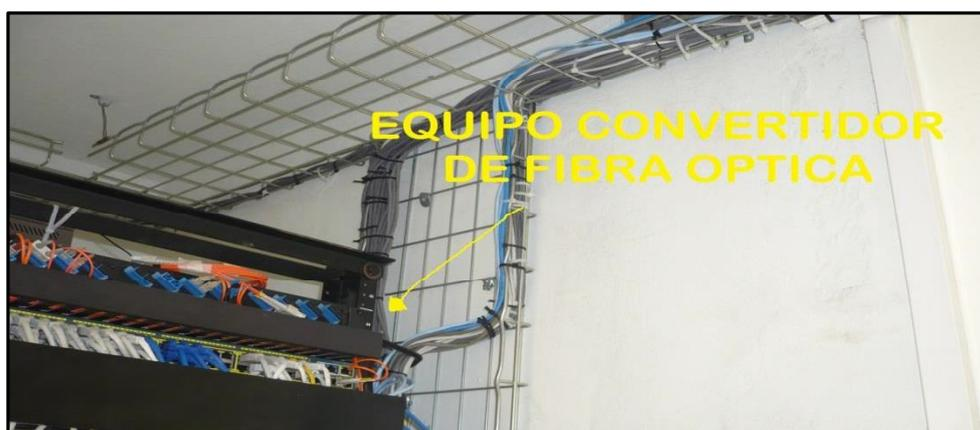
*Figura 3.8 equipos de conexión a pc y convertidores*
