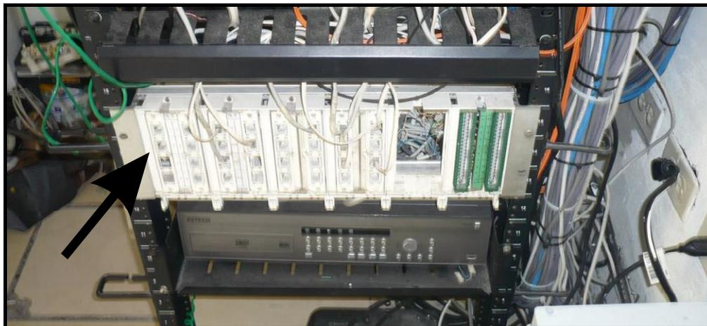
*Figura 3.6 Muestra el Mal Estado de la Central Telefonía*
