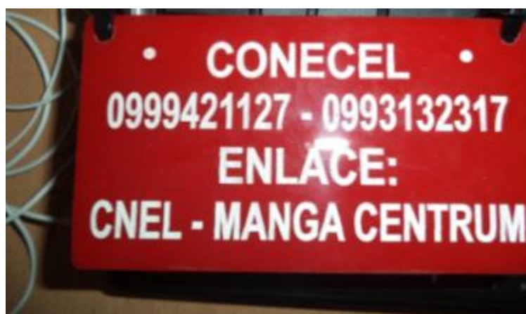
Figura 5.2: Etiqueta CLARO medidas 3 mm de espesor 7x12 cm Fuente: (Lorenti, 2014)
