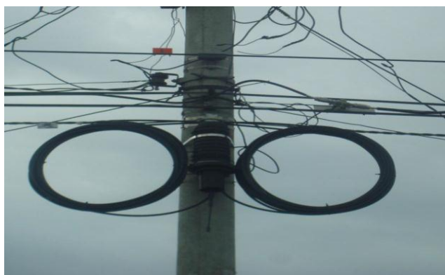
Figura 5.6: Reserva de fibra óptica Fuente: (CNT, 2012)
