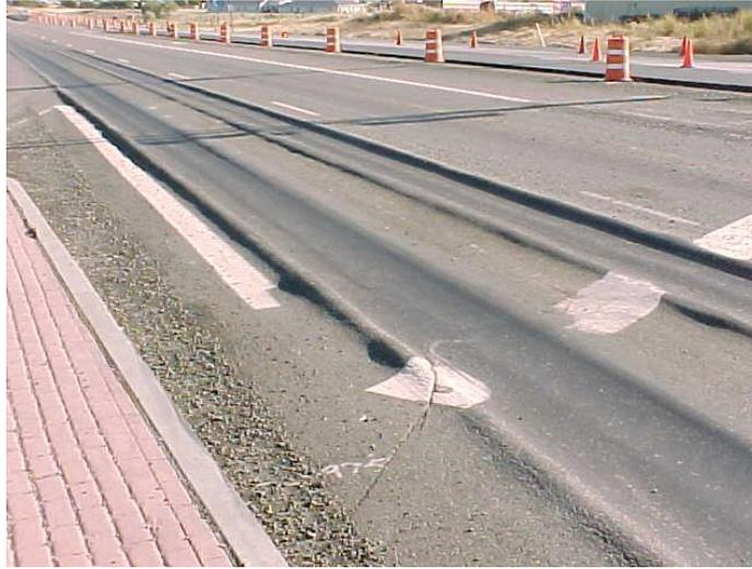
**Gráfica 2-3 Ahuellamiento severo de pavimento (tomado de [pavementinteractive.org](http://pavementinteractive.org))**
