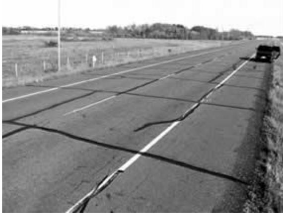
**Gráfica 2-7. Ejemplo de agrietamiento por temperatura (Tomada de ASTM.org)**
