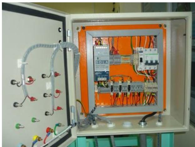
**Figura # 46** Tablero de control de banco de pruebas previa modificación.
