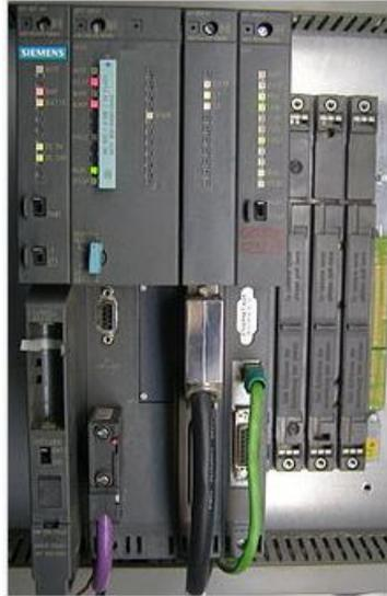
**Figura # 1** Es un rack UR2 de 9 ranuras, fuente de alimentación PS 407, CPU 416-3, módulo de interfaz IM 460-0 y procesador de comunicaciones CP-443-1
