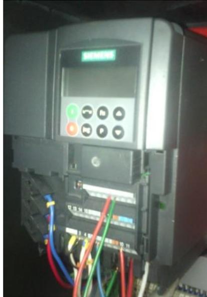
**Figura # 70 Variador de frecuencia Micromaster 440.**
