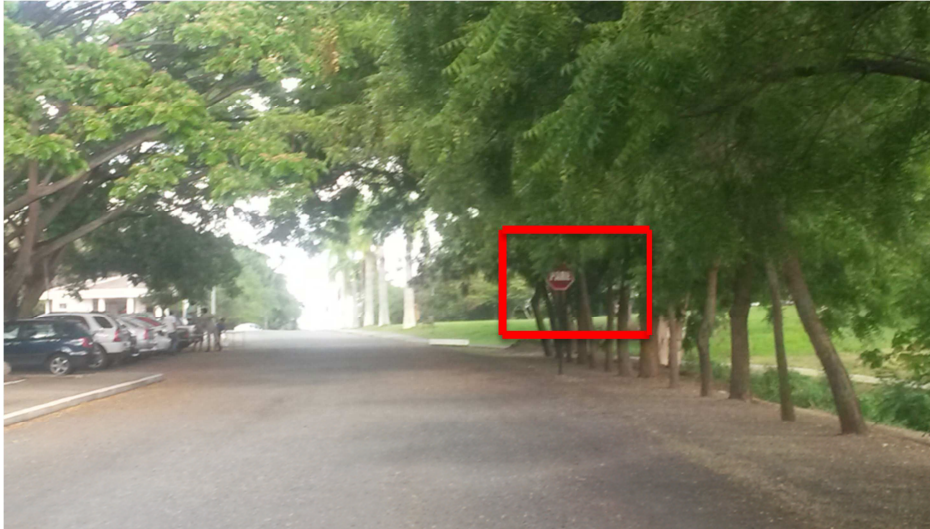
Imagen 6 Poca visibilidad de señales preventivas por falta de podar los arboles
