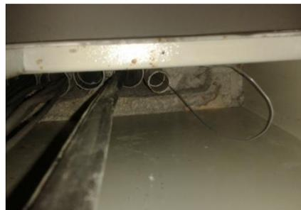
**Figura 3. 5** Tuberías de acceso horizontal hacia los Dptos., Centro Comercial Plaza Lagos.
