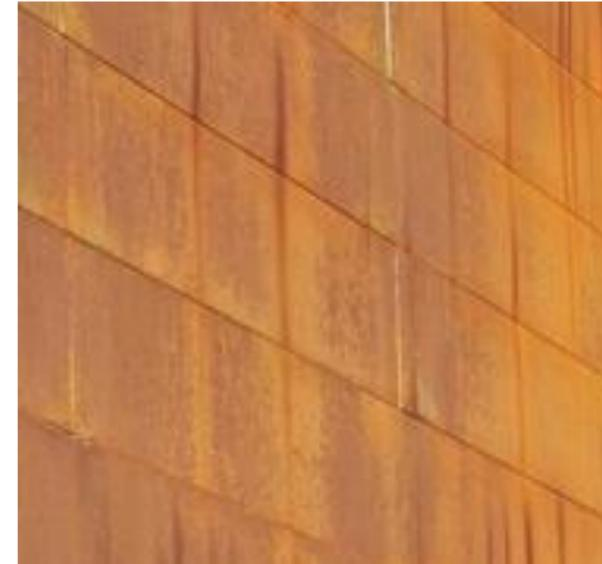
Figura 108: Multipanel F en versión Corten con textura arenada. Fuente: HunterDouglas
