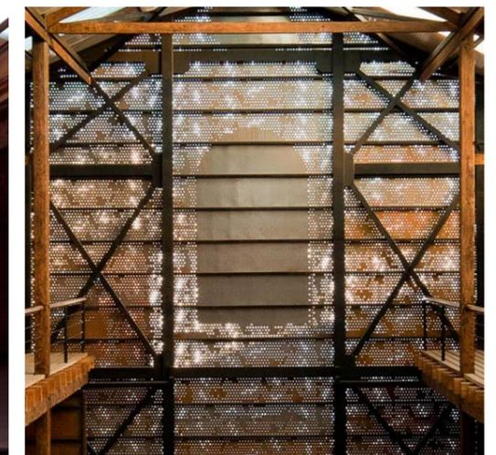
Figura 81: Fachada de acero corten. Fuente: Plataforma Arquitectura
