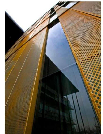
Figura 109: Panel Screen Corten con terminación perforada. Fuente: HunterDouglas
