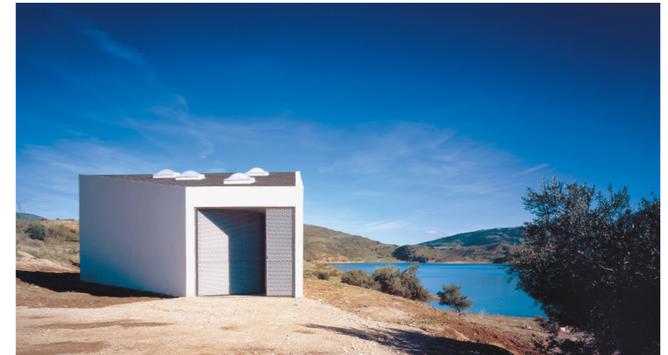
Figura 32: Vista fachada hacia el lago. Fuente: Elaboración propia.
