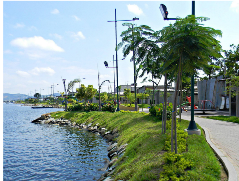
Figura 25: Reconformación del talud con enrocado y capa vegetal. Fuente: Elaboración propia.
