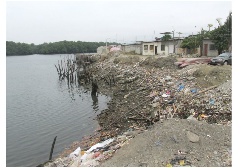
Figura 15: Fotografía de la situación de la ribera desde el agua. Fuente: Elaboración propia.
