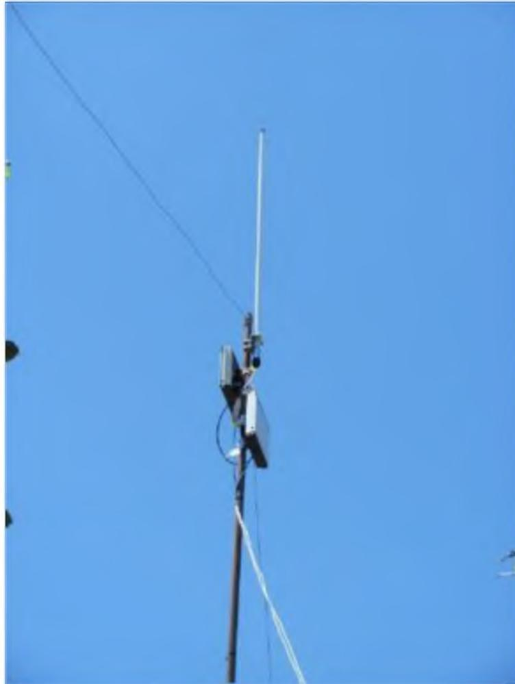
**Ilustración 44:** Grafico de ANTENA OMNIDIRECCIONAL TP-LINK TL-ANT2412D Instalada
