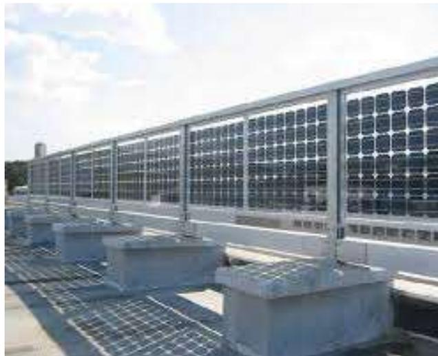
Figura 4. 13 *Diseño de paneles bifaciales.*
