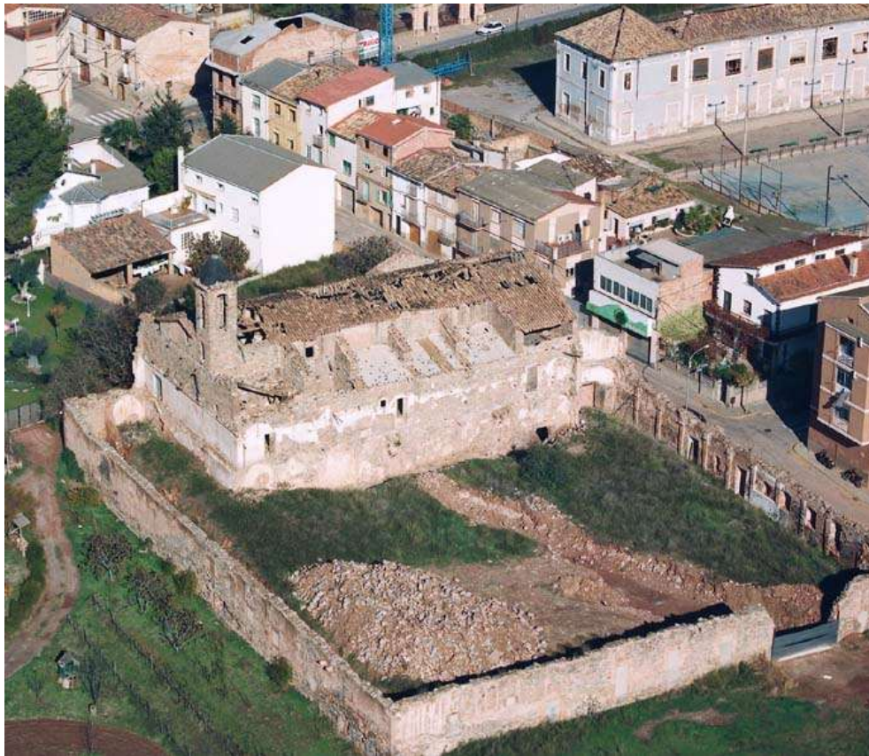
Figura 189: Edificio en ruinas Fuente: Closes (2011)
