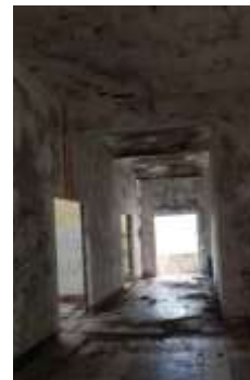
Figura 57: Pasillo ala izquierda Fuente: García (2014)
