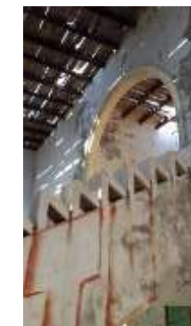
Figura 97: Escaleras, pasamanos Fuente: García (2014)
