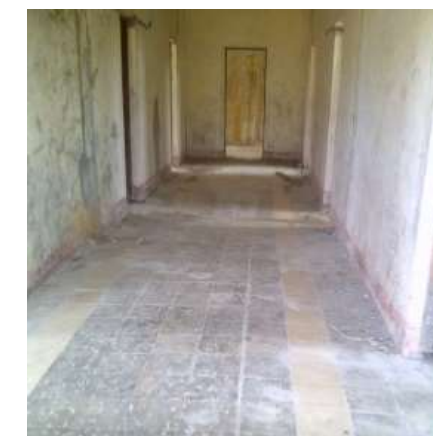
Figura 104: Piso en buen estado Fuente: García (2014)
