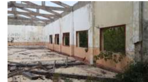
Figura 61: Estado cubierta, piso, ventanas. Fuente: García (2014)
