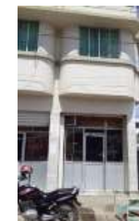
Figura 7: Dpto. de Obras Públicas fuera de la edificación Municipal
