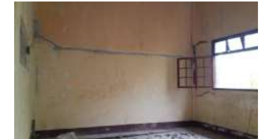
Figura 72: Grieta en pared Fuente: García (2014)
