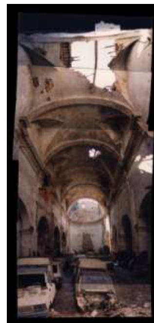
Figura 191: Vista interior edificación Fuente: Closes (2011)
