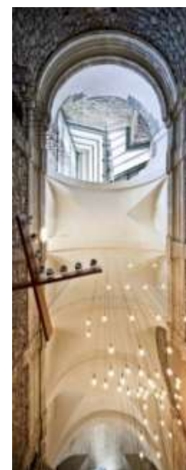
Figura 192: Interior edificación después de restauración Fuente: Closes (2011)
