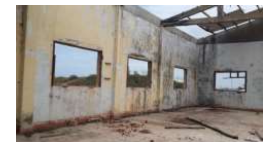
Figura75: Cubierta, paredes, piso Fuente: García (2014)
