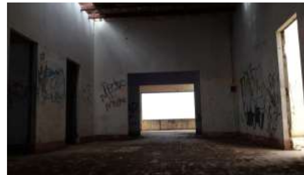
Figura 90: Vista hacia el balcón Fuente: García (2014)
