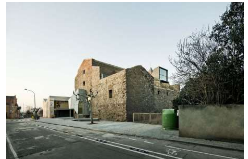
Figura 199: Vista posterior de la Edificación
