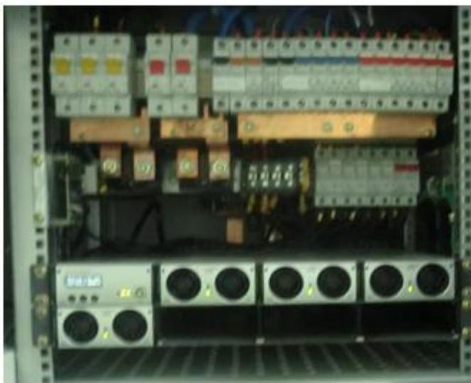
Figura 4. 6: *Power Eltek instalada y los breakers con las barras de tierra.*
