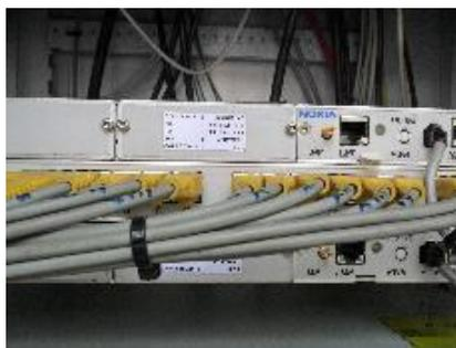
Figura 4. 10 : Equipo para radioenlace TDM Nokia Flexihopper.
