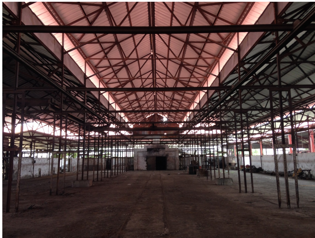
Ilustración 41 Cerchas de cubierta. Fuente: Grupo de Trabajo UTE, 2014
