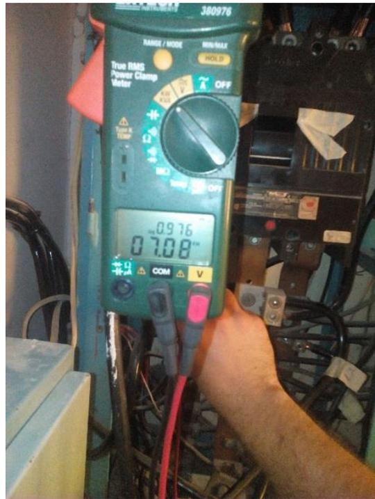
Figura 44. Medición del Factor de Potencia Fase S. Fuente: Autor
