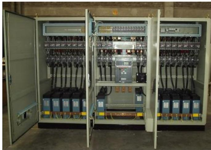
Figura 19. Banco de Capacitores Automáticos. Marca ONRAN Perú. Fuente: (Catalogo Onran, 2012)
