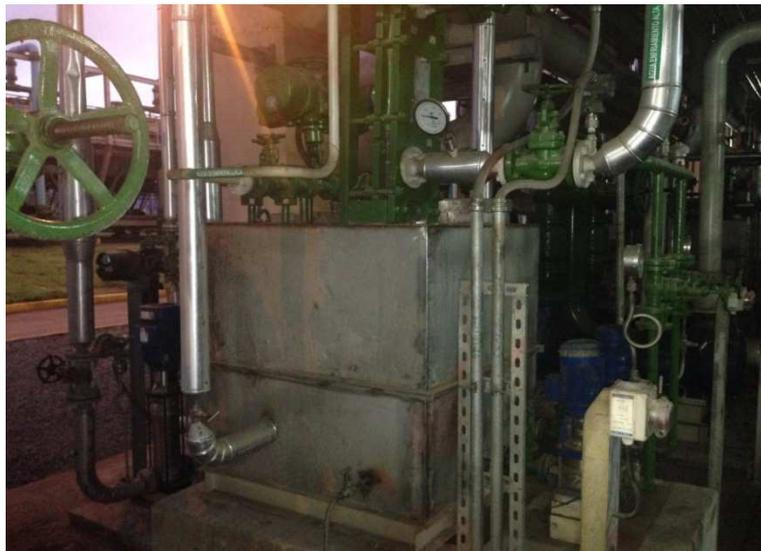
Figura 2. 19Módulo de radiadores para enfriamiento de agua de HT Y LT
