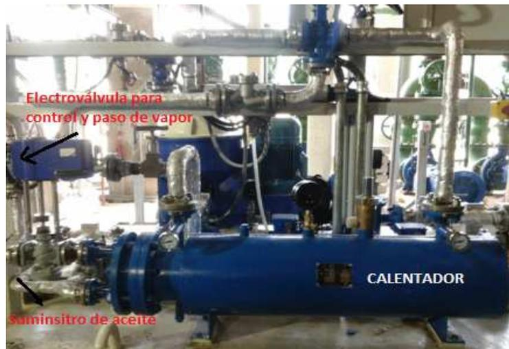
Figura 2. 15 Módulo de Separación de Aceite
