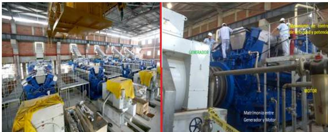
Figura 2. 12 Instalación de motores de combustión y generadores eléctricos
