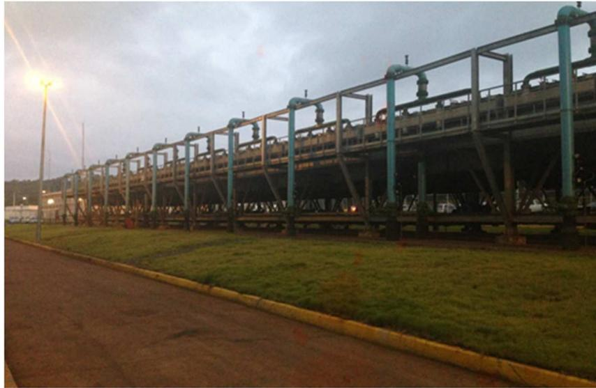
Figura 2. 20 Radiadores en la Central Termoelectrica Esmeraldas
