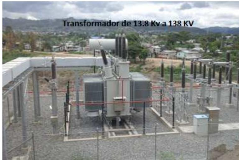
Figura 2. 25 Transformador de alto voltaje
