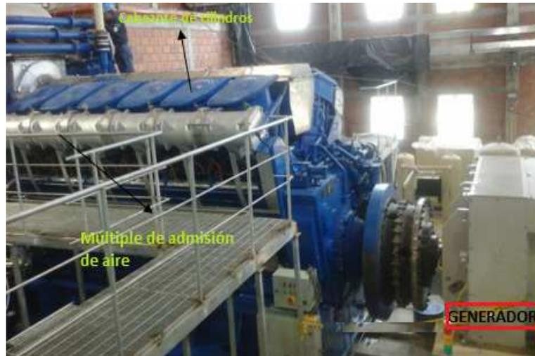
Figura 2. 23 Vista del motor y su generador
