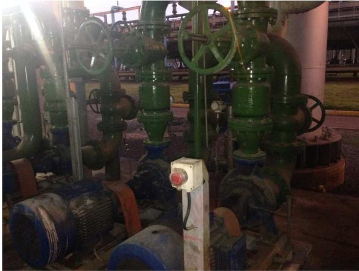
Figura 2. 18Módulo de agua para los Inyectores
