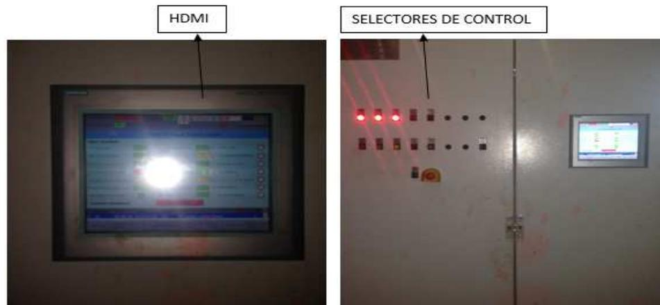
Figura 3. 2 HMI para monitoreo de variables de funcionamiento de motores
