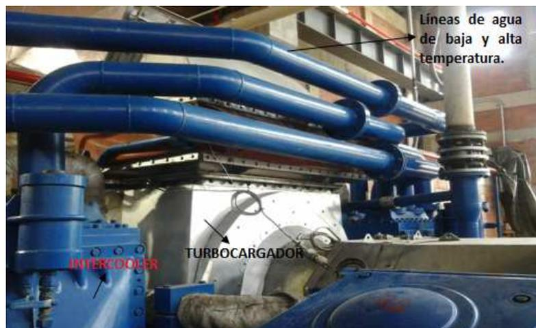
Figura 2. 21 Instalación de líneas de agua del turbocargador del motor de combustión
