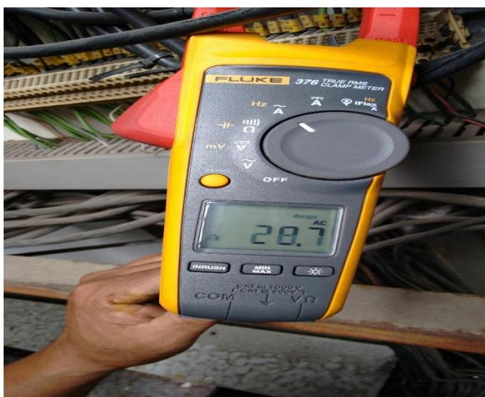
*Figura3.1:(Toma de corriente de línea en motores del sistema climatización)*
