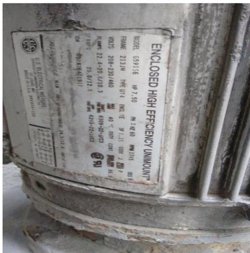
Figura 3.2.:(placa nominal del motor de 7,5hp)
