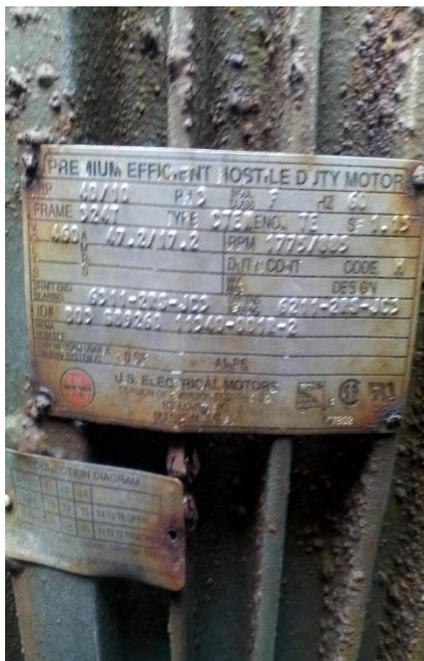
Figura: 3.3(placa nominal del motor de 40 hp del mecanismo de ventilación)
