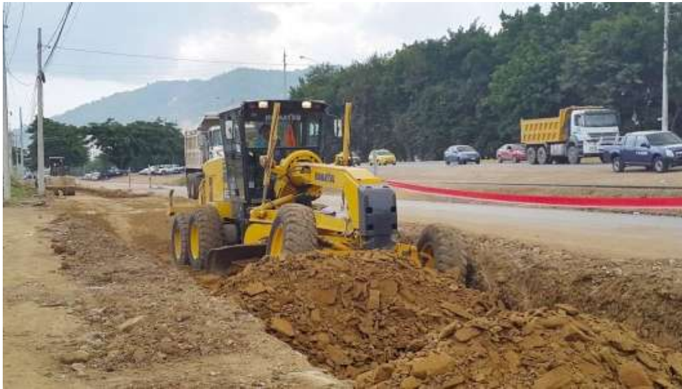
Foto 3: Vía de acceso en construcción sector Puerto Azul (Autor: Juan Ignacio de la Fuente)
