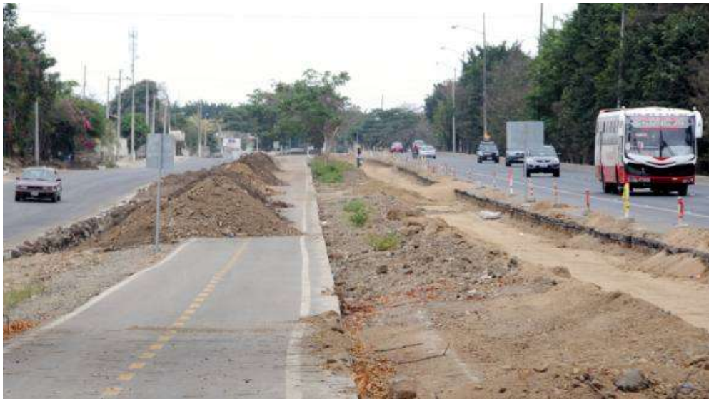
Foto 2: Vía de acceso en construcción (Autor: Juan Ignacio de la Fuente)
