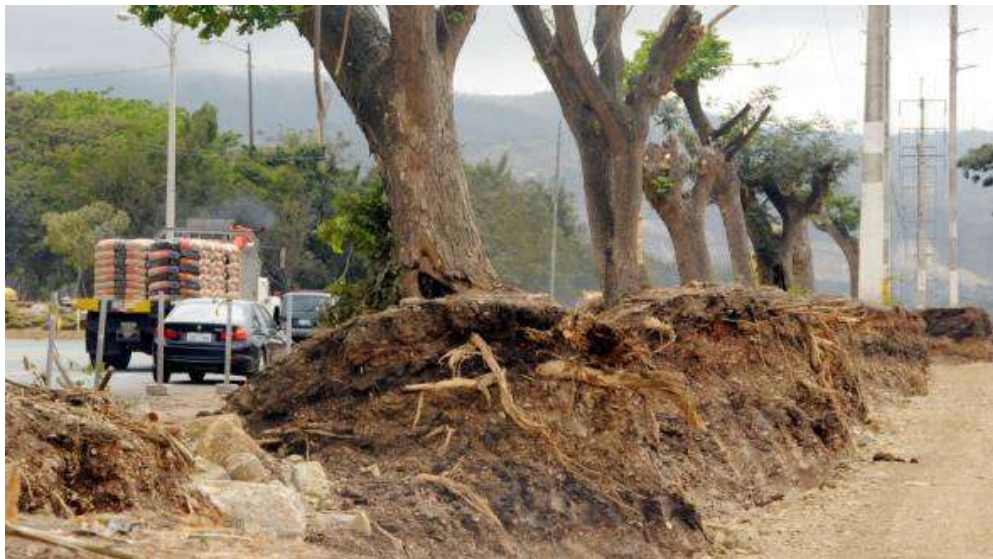
Foto 6: Vía de acceso en construcción sector Cerro Blanco (Autor: Juan Ignacio de la Fuente)
