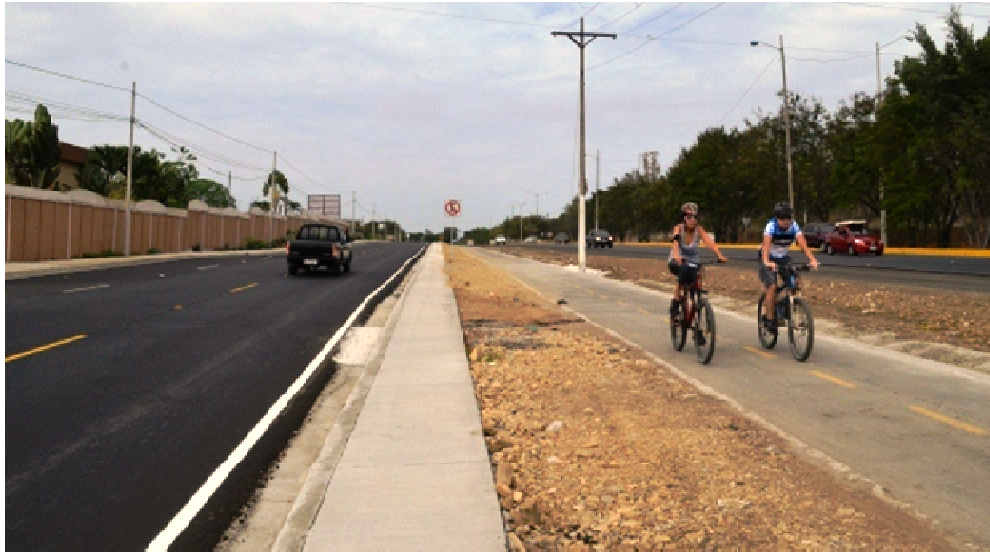
Foto 1: Vía de acceso terminada sector Terranostra (Autor: Juan Ignacio de la Fuente)
