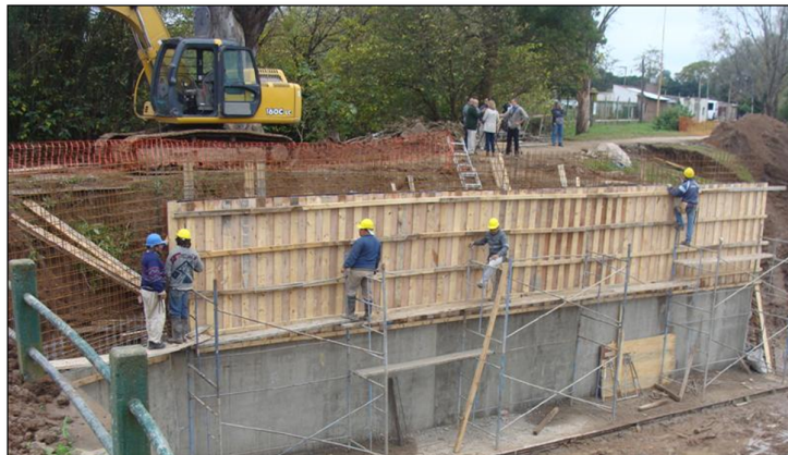
Figura 11: Muro de hormigón armado
