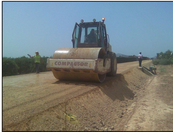
Figura 8: Compactación de terreno
