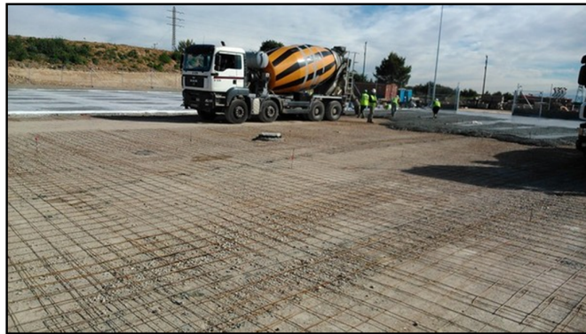
Figura 9: Pavimento de hormigón armado preparado para su posterior hormigonado
