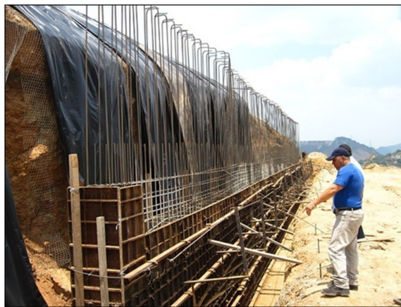
Figura 10: Preparación de muro de contención
