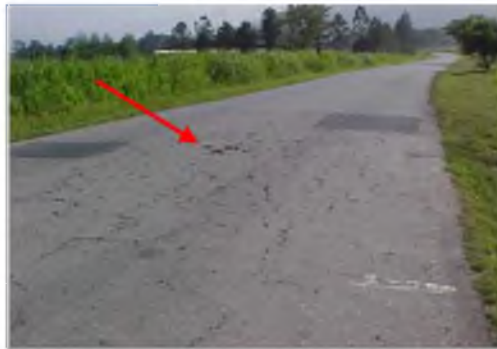
Ilustración 3: Agrietamiento por fatiga del pavimento
