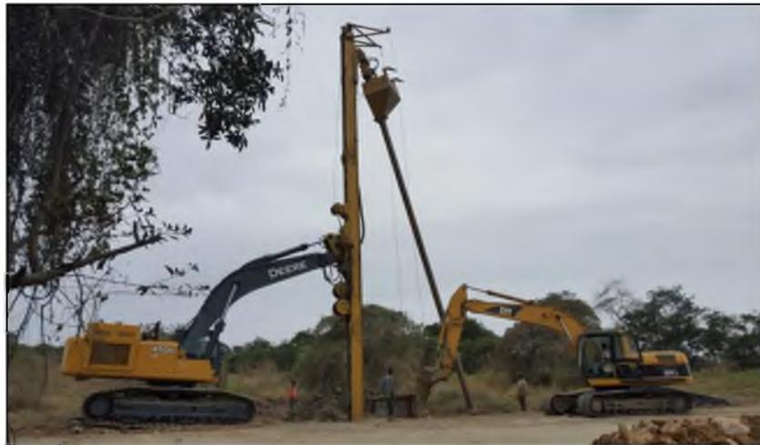
Armado de Equipos se observa la torre con el tubo de perforación y la tolva
