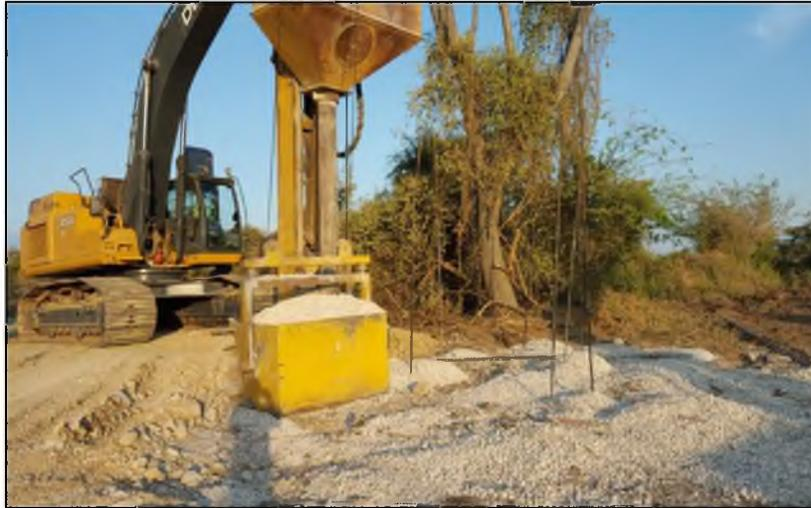
Columnas formadas con placas de control de asentamiento para su uso en las prueba de carga
